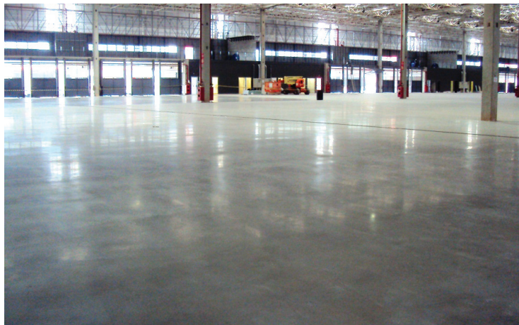
Piso do Centeranel Raposo executado pela Fernandes Engenharia foi o vencedor da edição 2011
