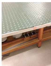
(d) Fixação final do piso dissipativo sobre base de concreto.
