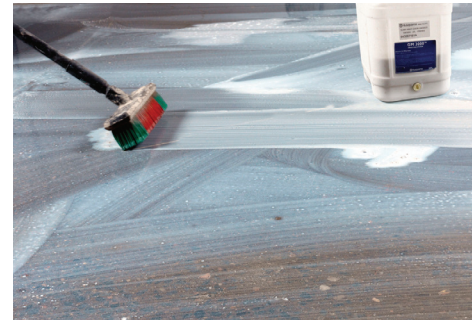
Figura 5. Passando o estucador
