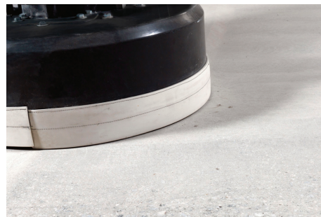
Figura 4. Desbaste do piso de concreto
