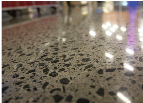
Figura 1. Concreto polido para fins decorativos
