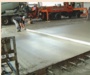
Piso executado pela GNP para a Liotécnica é quatro vezes mais nivelado que a média dos pavimentos construídos no Brasil no mesmo período
